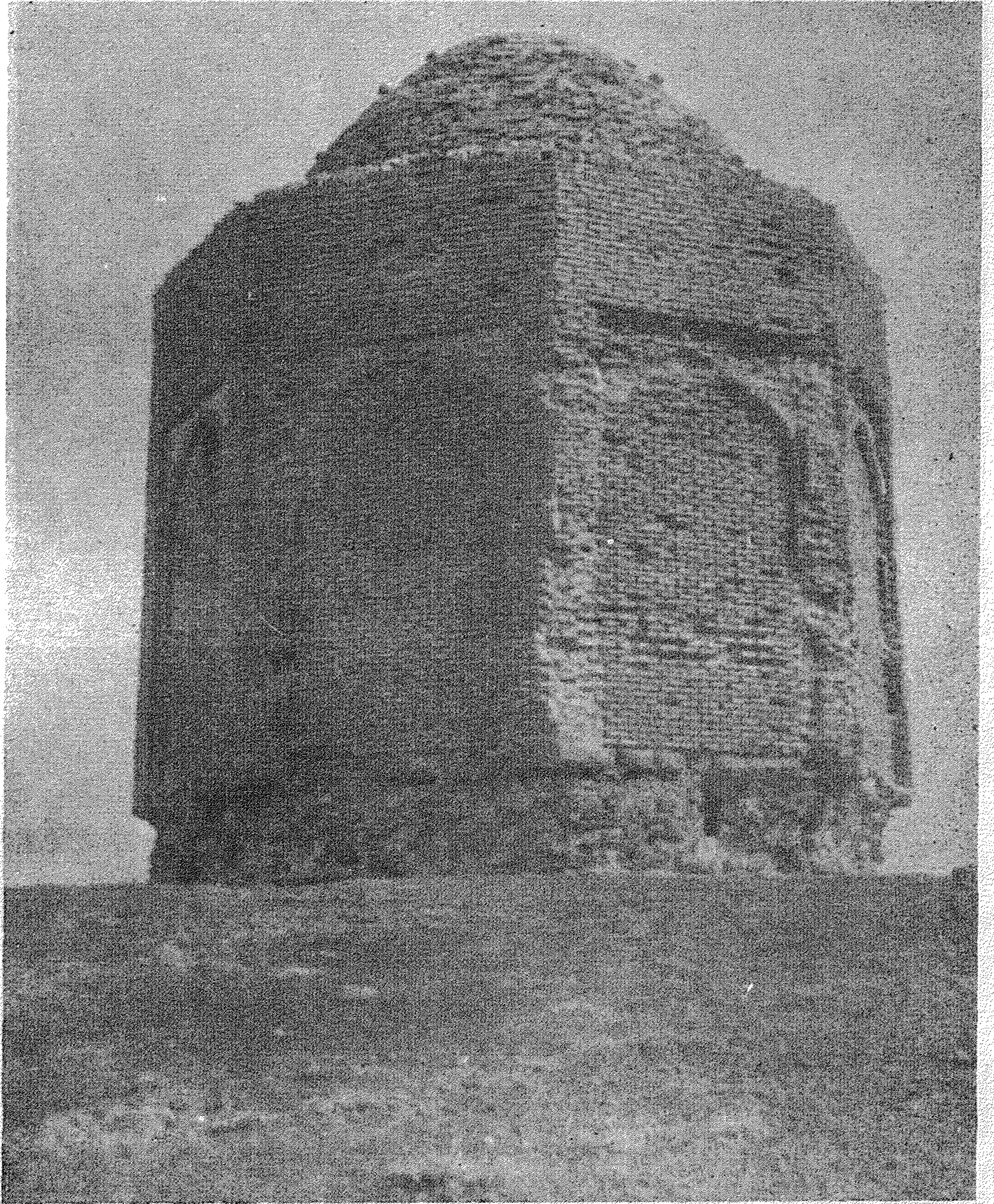
۴۶- سنقر - مقبره‌ای به صورت برج در سنقر آباد - ده جزء دهستان کندوان بخش ترک شهرستان میانه
